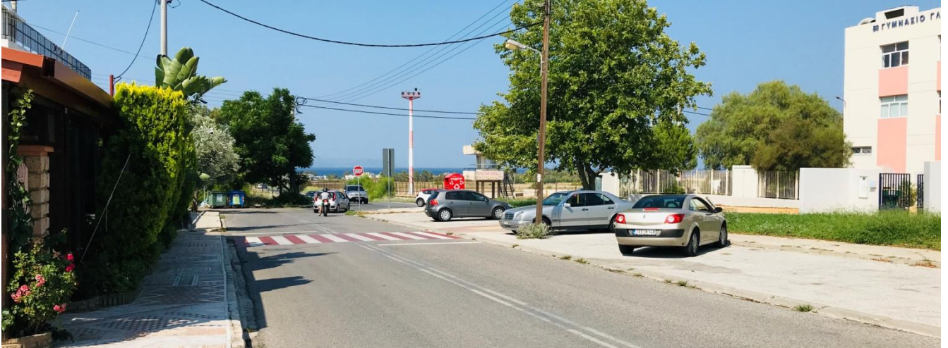
Εικόνα 6: Διάβαση πεζών, επί της οδού Ροδόπης, στο ύψος του 13ου Νηπιαγωγείου & 8ου Γυμνασίου (Πηγή: αυτοψία αναδόχου)
