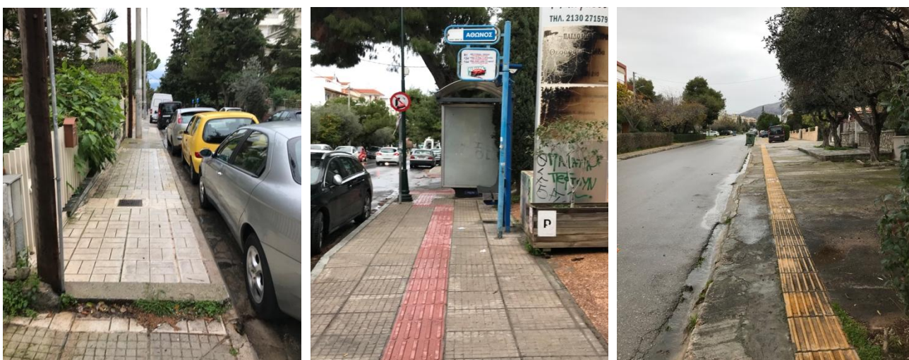
Εικόνα 10: Ενδεικτική απεικόνιση υφιστάμενων πεζοδρομίων στις οδούς Τριπόλεως, Γ.Γεννηματά και Αριστοφάνους (Ανω Γλυφάδα) (Πηγή: αυτοψία αναδόχου)
