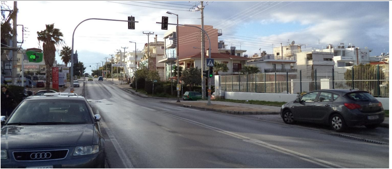
Εικόνα 5: Πεζοφάνηρο επί της οδού Γούναρη, στο ύψος του 14ου Δημοτικού σχολείου (Πηγή: αυτοψία αναδόχου)
